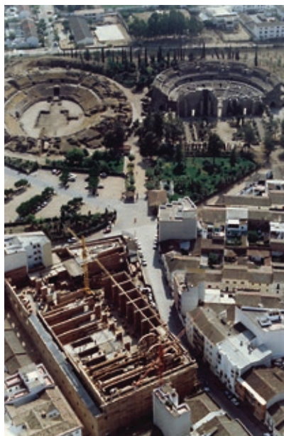
► Muzej rimske umjetnosti, Mérida, Španjolska, 1980.–1986., pogled iz zraka za vrijeme izgradnje ► Museum of Roman Art, Mérida, Spain, 1980–1986, areal view during construction
